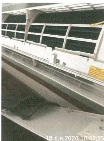
รูปภาพที่ 2.46 การล้างเครื่องปรับอากาศ
