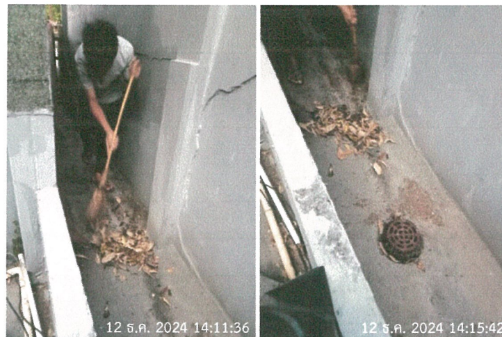
รูปภาพที่ 2.18 การขุดลอกรางระบายน้ำ
